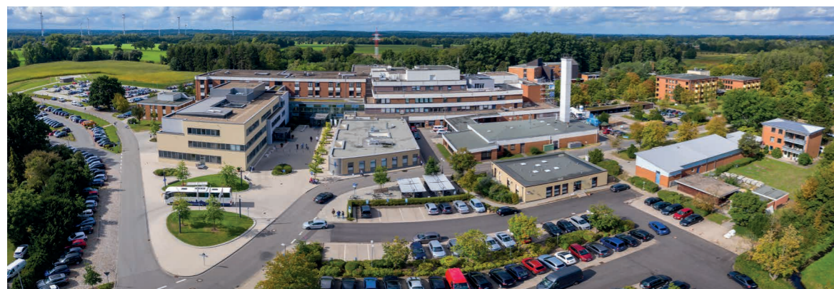
← Das Krankenhaus kurz nach Eröffnung des Notfall- und Diagnostikzentrums: Vorne in der Mitte das Ärztehaus von 2008, links davon das Notfall- und Diagnostikzentrum und links oben der neue Hubschrauberlandeplatz
