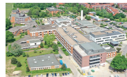
↓ Der neue Bettentrakt kurz vor der Inbetriebnahme Mitte 2022
